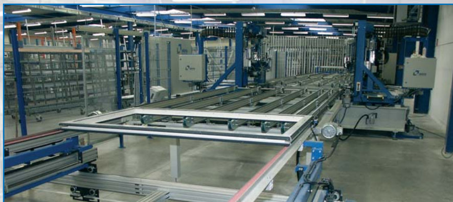
Ein Personaleinsatz ist auf der gesamten Wegstrecke nur beim Einlegen der zugeschnittenen Profile in den Schweißautomaten, der teilautomatischen Beschlagmontage und der Elemente-Endmontage erforderlich.
